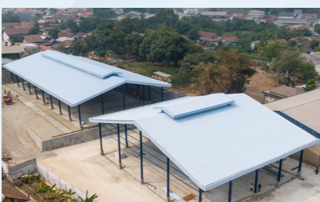
Project Pabrik Limbah
